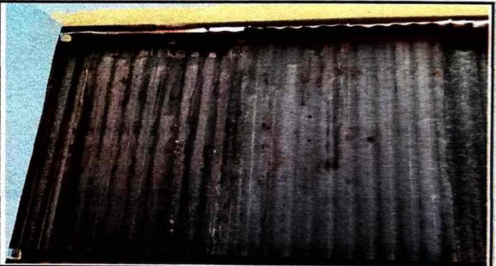
Foto 4: Se observa la presencia de humedad
