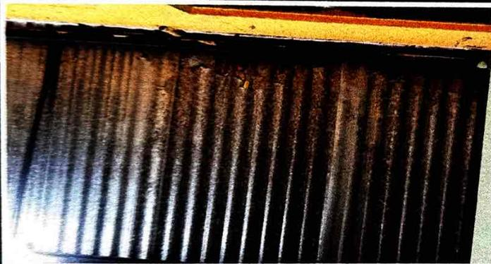
Foto 3: Se observa láminas oxidadas
